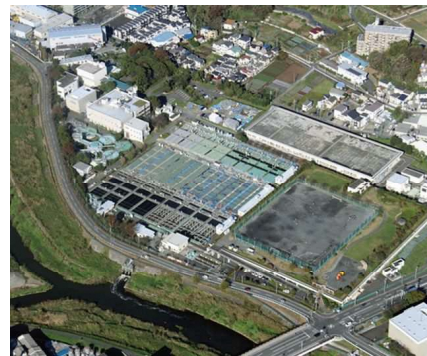
都筑水再生センター
