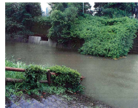
増水時の川向付近の状況
